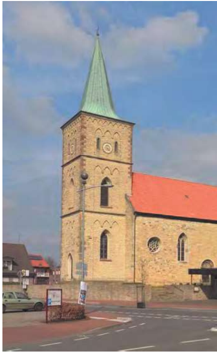
Die Gemeinde Heek (hier die katholische Pfarrkirche) nutzt das BIL-Portal für die Erbringung der Leitungsauskunft.
