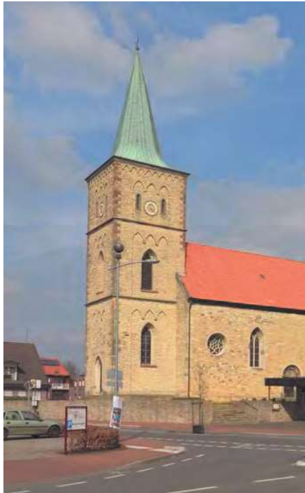
Die Gemeinde Heek (hier die katholische Pfarrkirche) nutzt das BIL-Portal für die Erbringung der Leitungsauskunft.
