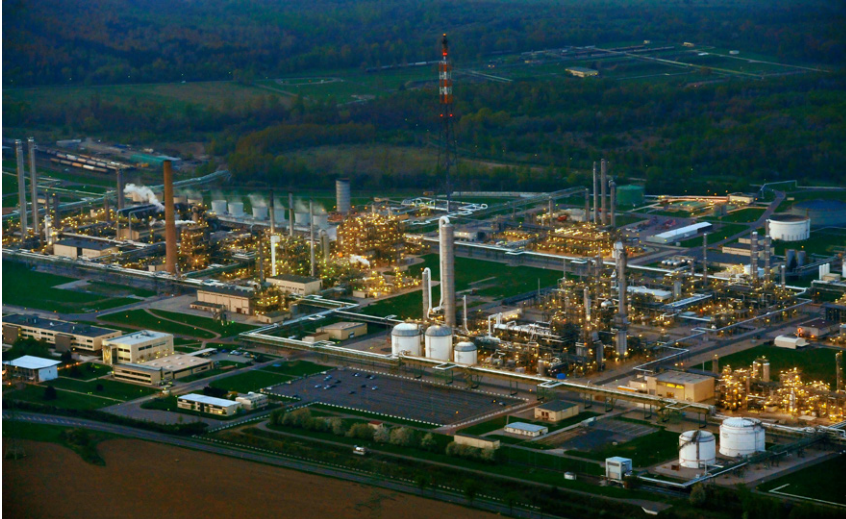
Das Dow-Werk Böhlen ist über eine 430 Kilometer lange Pipeline mit dem Seehafen in Rostock verbunden, über die ein Großteil der Rohstoffe angeliefert wird. (Foto: Dow / Horst Fechner)
