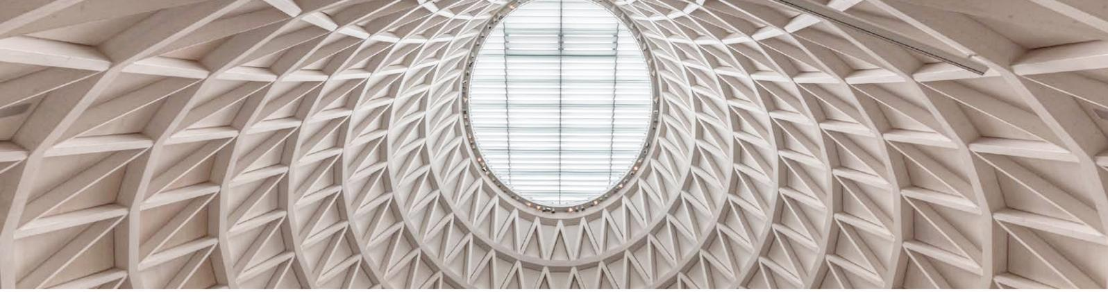
**Blickpunkt der Ausgabe 3/2022:** Bauen mit Holz und Herz: Die Holzkirche in Holzkirchen wurde als Kegelstumpf auf elliptischer Grundfläche mit leicht gekippter Mittelachse und geneigten Oberlichtern konstruiert. Das Dach aus Balken und Holzschindeln bietet mit jeder leichten Perspektivänderung neue Eindrücke. Foto: P. Born, www.fotografie-pb.net
