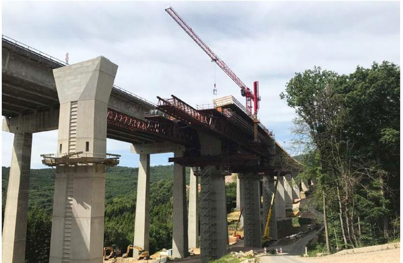
wurde der Vorläufer demontiert. Da das Vorschubgerüst auch bei dem Bau des zweiten Teilbauwerkes zum Einsatz kommen soll, entschieden sich die Beteiligten dafür, es vor Ort zu belassen. So wurde nach Fertigstellung des 11. Taktes das Vorschubgerüst zurück in das vorherige Brückenfeld gefahren und dort mit Hilfe von Litzenhebern komplett abgelassen.
