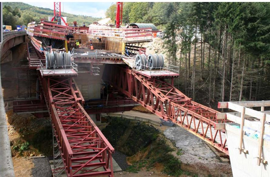
Das Vorschubgerüst muss der Querneigungen der späteren Fahrbahn folgen. Thyssenkrupp Infrastructure löste dies durch die Kombination von höhenverstellbaren Auflagerschlitten im Bereich der Pfeilereinrüstung mit einem Hydrauliksystem. Foto: Thyssenkrupp Infrastructure
